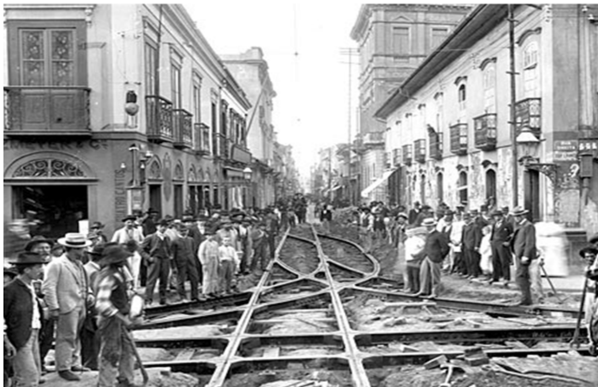
Figura 1 – Construção dos trilhos de bondes no centro de São Paulo
