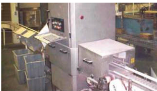
Instalação de uma radioscopia em uma linha de inspeção de produtos alimentícios embalados.
