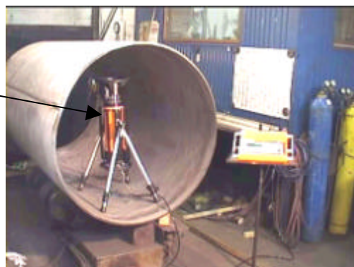
Inspeção radiográfica de soldas em tubos
